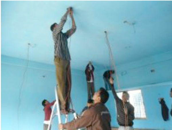
Die Lehrlinge installieren ein Klassenzimmer
