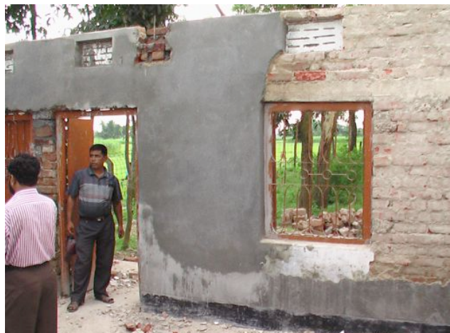
Renovation für ein Schulhaus
