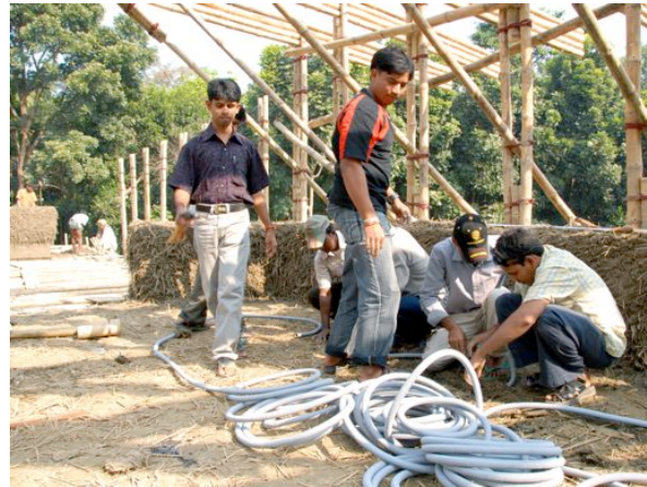
Verlegen der Elektro-Rohre
