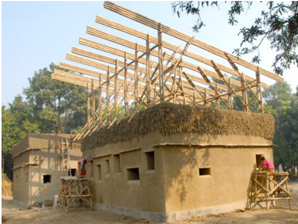
Zweistöckiges Schulhaus im Rohbau
